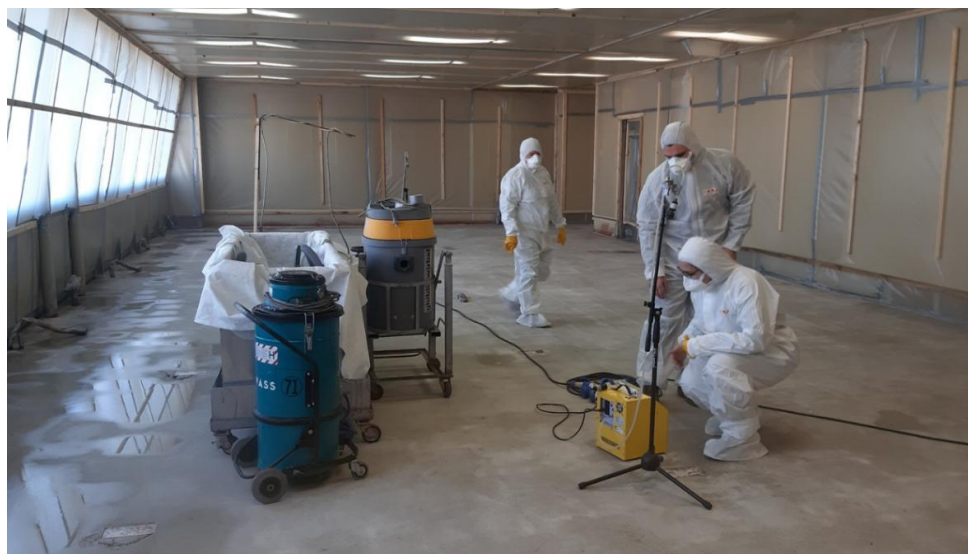
Figura 49 - campionamento di restituibilità
